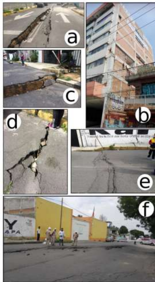
Figura 5. Panel de fotos de fracturas y edificios afectados en la zona oriente de la Ciudad de México durante el sismo del 19 de Septiembre de 2017: (a) Calle Piraña; (b) Calzada de la Viga; (c) Col. La Planta; (d) Santa María Aztahuacán; (e y f) Calle Cuauhtémoc, Santa María Aztahuacán.
