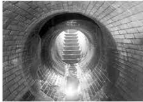
Alcantarillado de la era Victoriana
